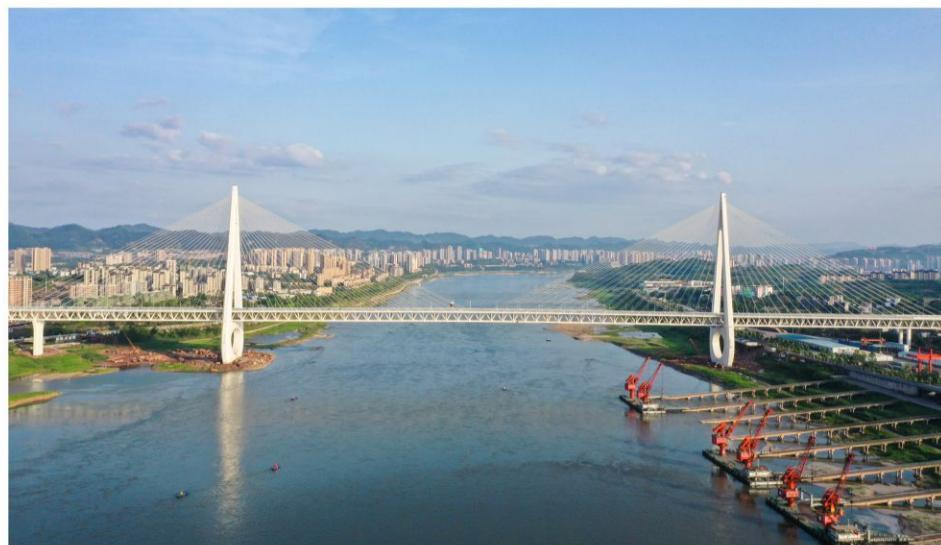
2022年1月24日，白居寺长江大桥建成通车。该工程全长约3.7公里，连接重庆市巴南区和大渡口区，其中跨江主桥长1384米，主跨660米，为世界最大跨径公轨两用钢桁梁斜拉桥。远望大桥，高耸的塔桥仿佛一滴从天而降的甘霖，滴入碧浪奔涌的长江中。诚如容易却艰辛。空间异形结构水滴形桥塔如何确保精度质量？跨越老成渝铁路线的钢桁梁如何安全平稳合龙？面临大桥接踵而至的难题，建设者们在长江上演绎速度与激情。
