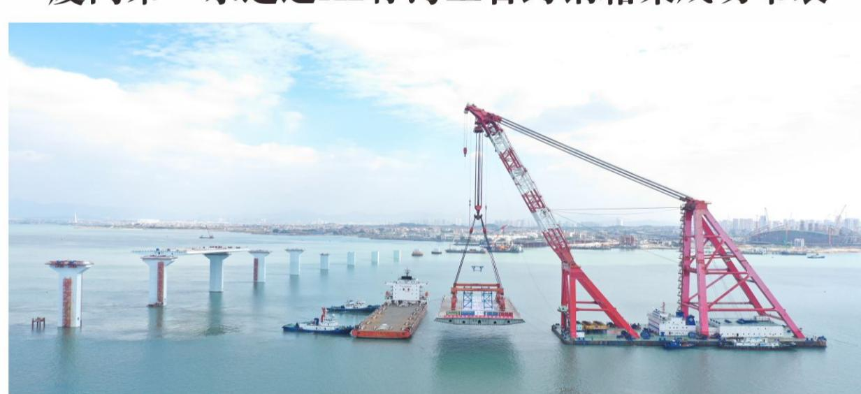
10月19日，厦门第二东通道（翔安大桥）A2标海上首跨钢箱梁成功吊装，大桥海中区桥梁进入上部结构装配化施工新阶段。
