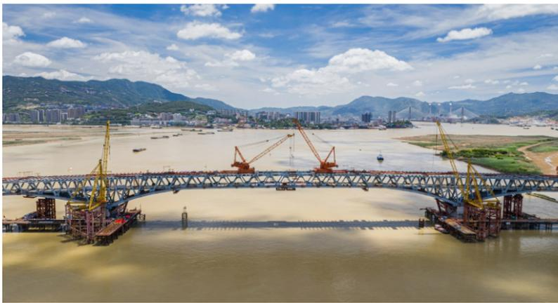
步精准对接，项目部不仅引入BIM技术确保钢梁制造的精度，并且采用跷跷板原理，以主墩为支点，升降墩墩来调整合龙口两端钢梁的位置。
