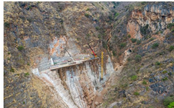
4月27日，随着右幅4#-1桩基终孔，华丽高速公路项目阿肯动大桥所有桩基全部开挖完成。阿肯动大桥位于哥石山隧道出口和十二栏杆坡隧道进口之间，桥梁两端桥台均直接连接隧道。全桥横跨深V型峡谷，地形险要。大桥左幅长172.6米，右幅长151.6米，共有桩基26根，全部采用冲孔桩。
