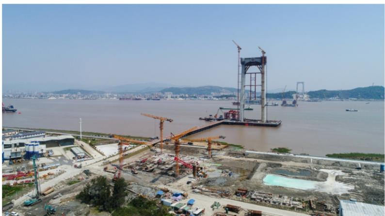
4月12日晚，随着最后一车填仓混凝土的浇筑，公司承建的温州瓯江北口大桥南锚碇沉井宣告施工完成，大桥建设取得突破性进展。
