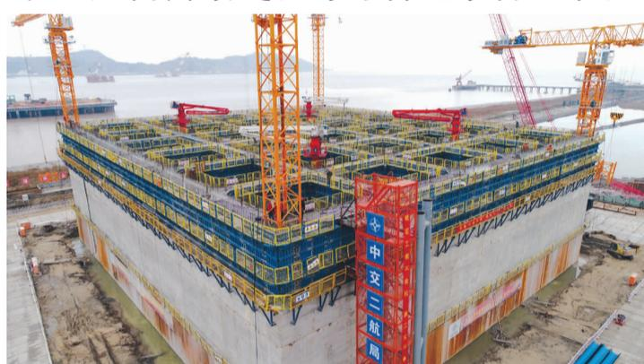
1月28日晚，公司温州瓯江北口大桥项目历时59小时完成南锚碇第三节混凝土沉井浇筑施工。至此，北口大桥南锚碇沉井第一次下沉前接高施工已全部完成。
