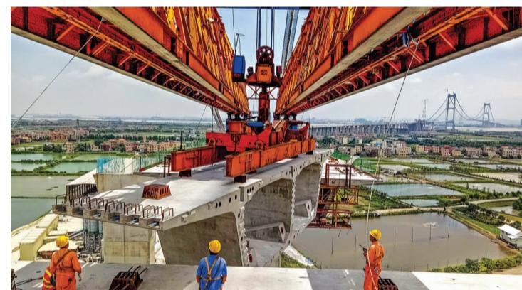
8月7日,公司虎门二桥S3标项目部完成第3000榀节段箱梁安装施工。这一重要节点的完成,标志着虎门二桥全线节段箱梁安装工作已进入最后冲刺阶段。
